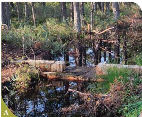
6 pav. Medinių spraustasielių (plotis 20 cm) pertvara su perteklinio vandens nutekėjimo anga, Svencelės aukštapelkė, Klaipėdos r., 2023 m. © Jūratė Sendžikaitė
