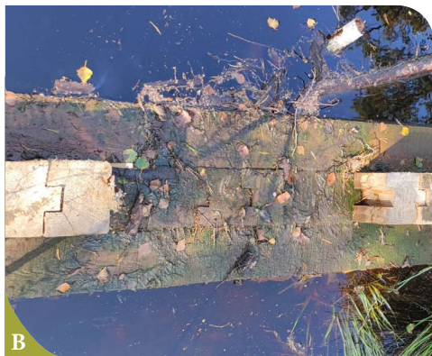
6 pav. Medinių spraustasielių (plotis 20 cm) pertvara su perteklinio vandens nutekėjimo anga, Svencelės aukštapelkė, Klaipėdos r., 2023 m. © Jūratė Sendžikaitė
