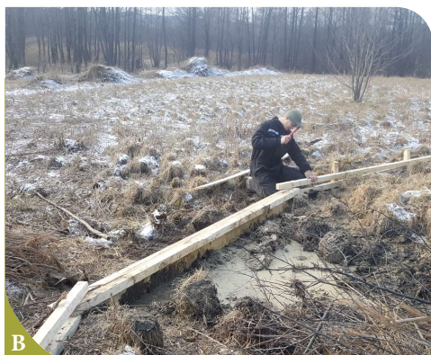
7 pav. Hidrologinio režimo atkūrimo priemonės Tartoko žemapelkėje, Prienai: A – plastikinių spraustasielių pertvara, B – pertvara iš vidutinio tankio medienos plaušų (MDF) plokštės. © Nerijus Zableckis
